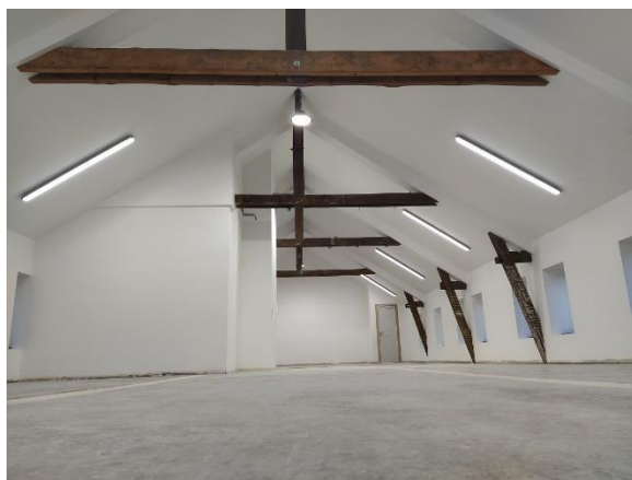
Aménagement de la nouvelle salle des archives
